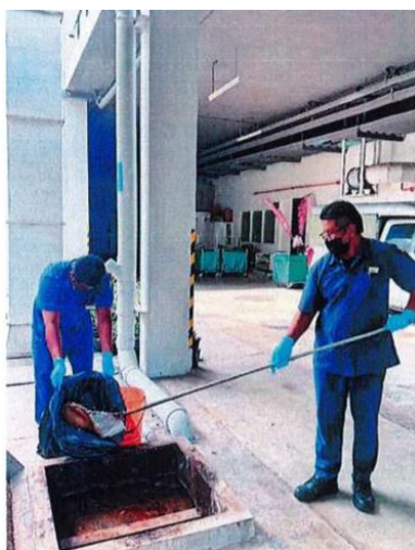
ภาพที่ 1-8 เจ้าหน้าที่ดักไขมัน และมิเตอร์ไฟฟ้าสำหรับระบบบำบัดน้ำเสีย
