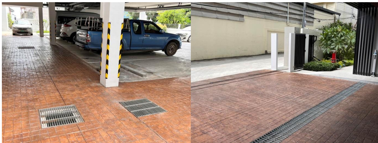
ภาพที่ 1-10 ระบบระบายน้ำฝนของโครงการ
